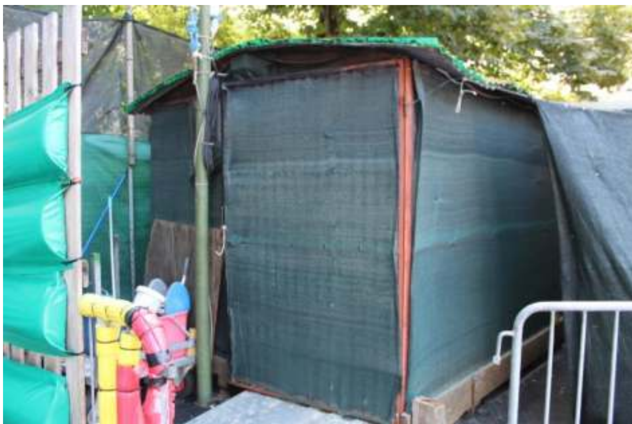
FOTO 8 – BOX IN LAMIERA DA DEMOLIRE
