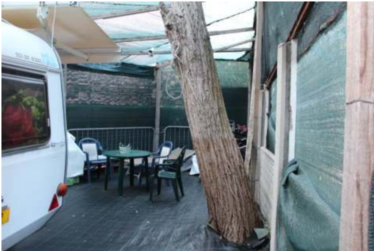
FOTO 7 – ZONA PERGOLA, MANUFATTO E MURATURA DA DEMOLIRE
