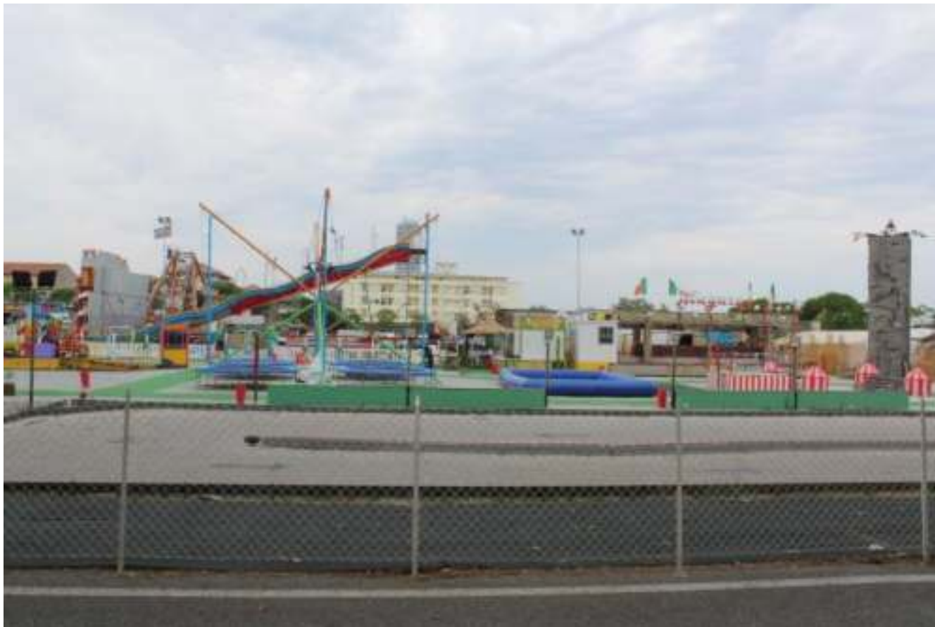
FOTO 9 – VISTA DA SUD – VIA VENEZIA
