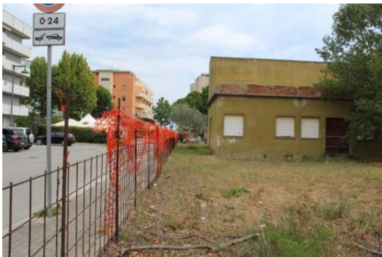
FOTO 6 – PROSPETTO NORD E OVEST IL MARCIAPIEDE E' LA PORZIONE DI TERRENO DA CEDERE GRATUITAMENTE AL COMUNE
