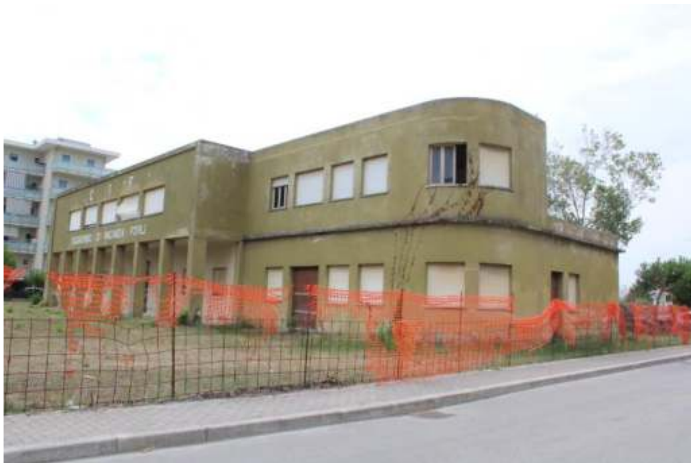
FOTO 3 – PROSPETTO EST VIALE CARDUCCI E LATO NORD VIA PANZINI. IL MARCIAPIEDE E' LA PORZIONE DI TERRENO DA CEDERE GRATUITAMENTE AL COMUNE
