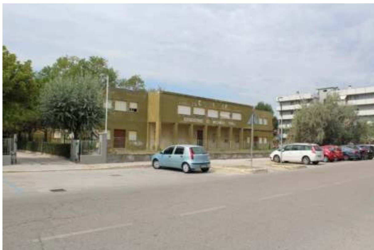
FOTO 2 – PROSPETTO VIALE CARDUCCI
