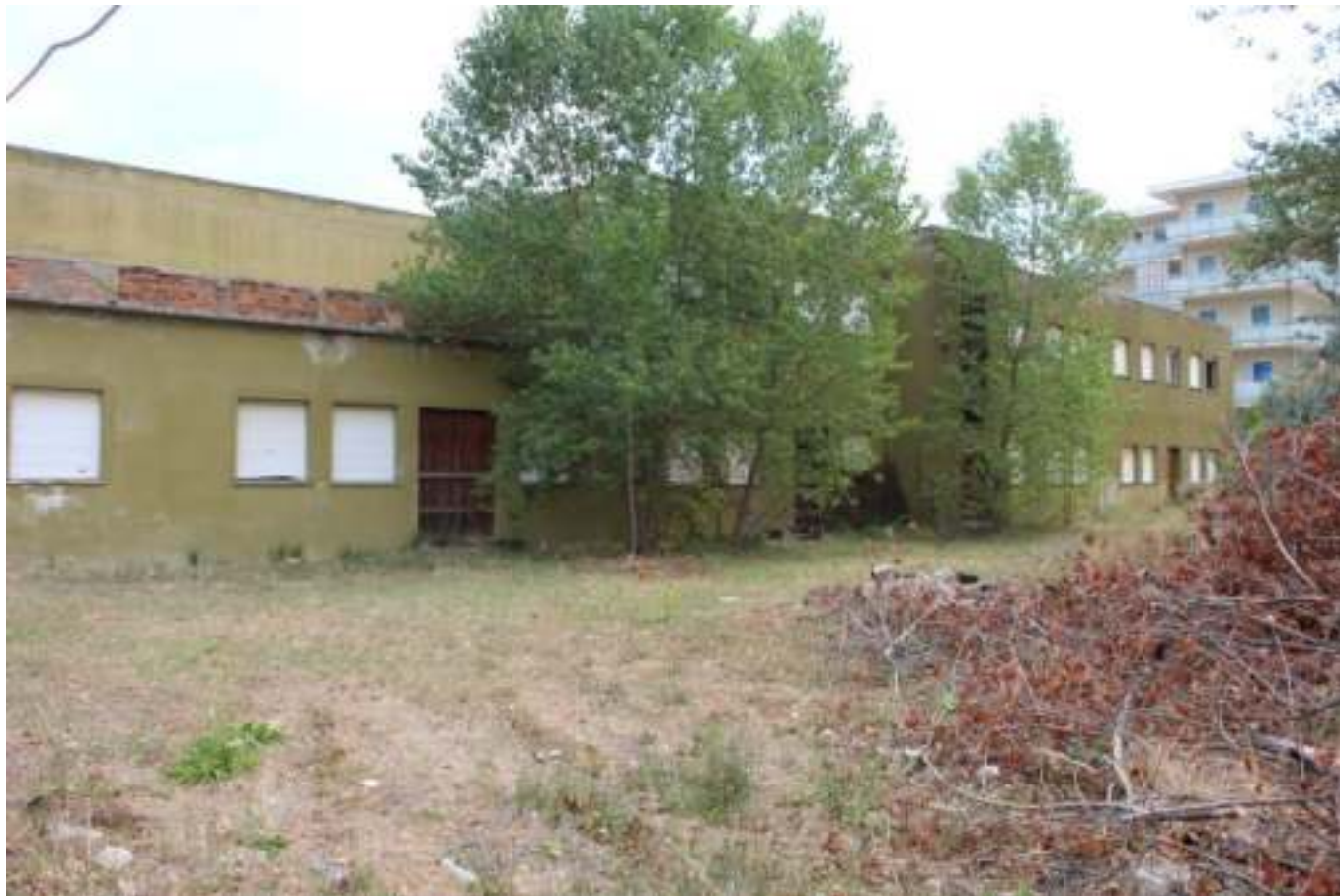
FOTO 7 – PROSPETTO OVEST – VIALE DEI MILLE
