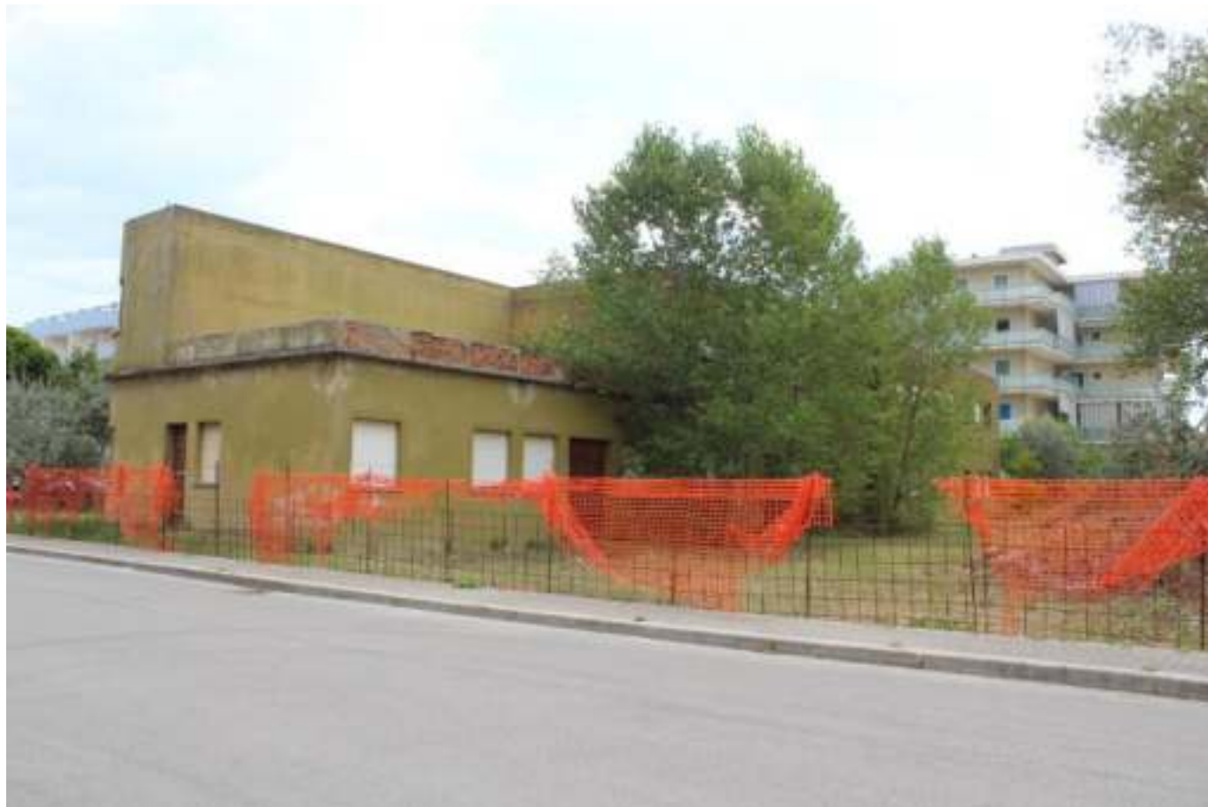
FOTO 5 – PROSPETTO NORD SU VIA PANZINI E OVEST IL MARCIAPIEDE E' LA PORZIONE DI TERRENO DA CEDERE GRATUITAMENTE AL COMUNE
