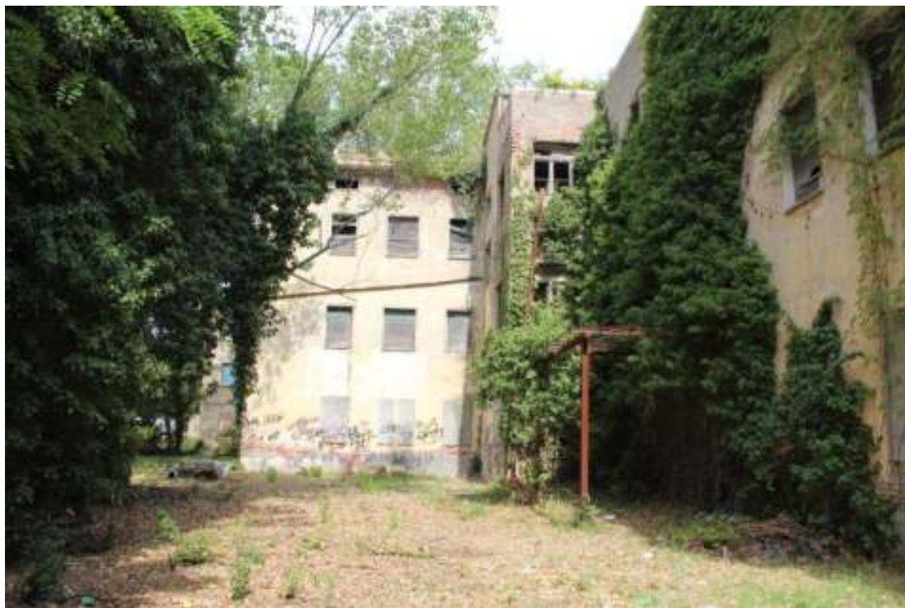
FOTO 9 – PROSPETTO SULRETRO, LATO VIALE DEI MILLE
