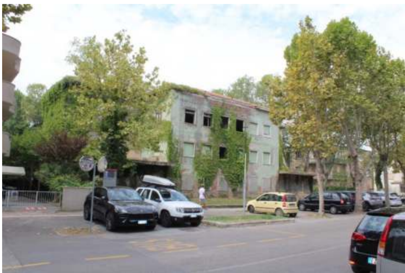
FOTO 2 – PROSPETTO VIALE CARDUCCI E LATO SUD
