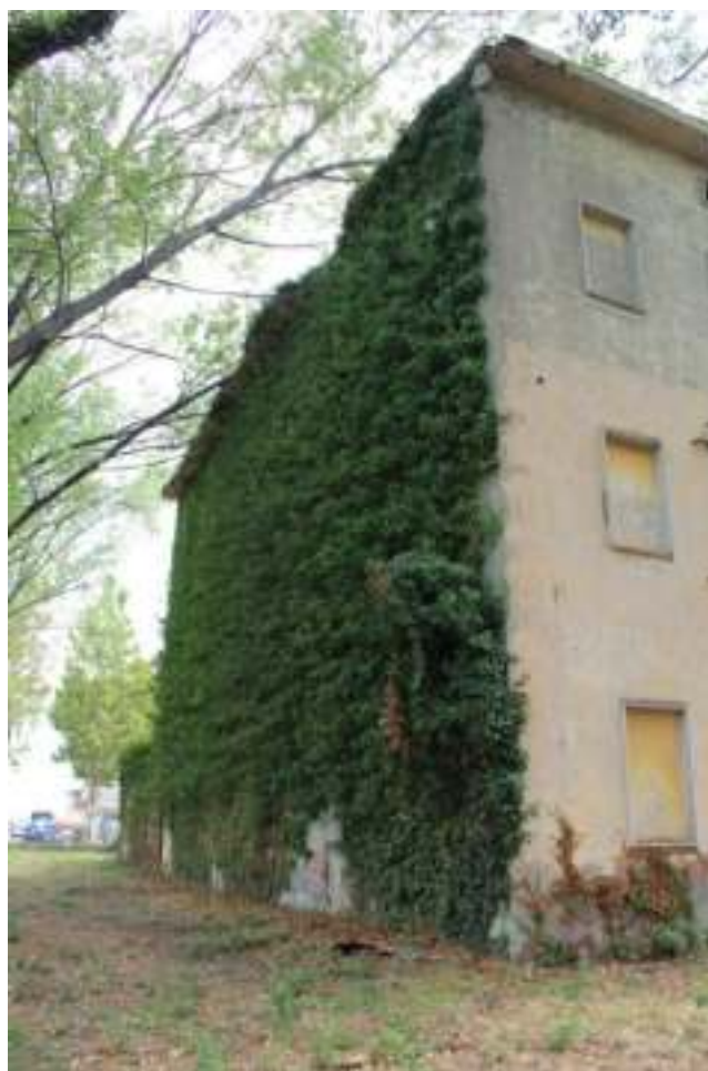
FOTO 8 – VISTA PROSPETTI NORD (sinistra) e OVEST (destra)
