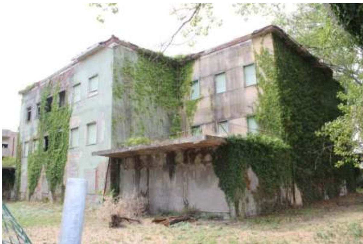
FOTO 4 – PROSPETTO VIALE CARDUCCI E LATO NORD
