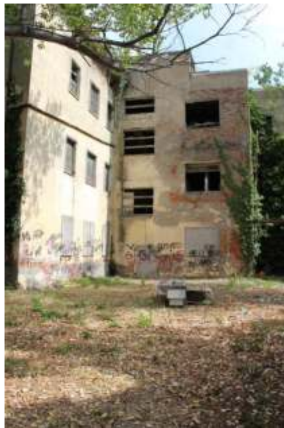
FOTO 6 – PROSPETTO OVEST – VIALE DEI MILLE
