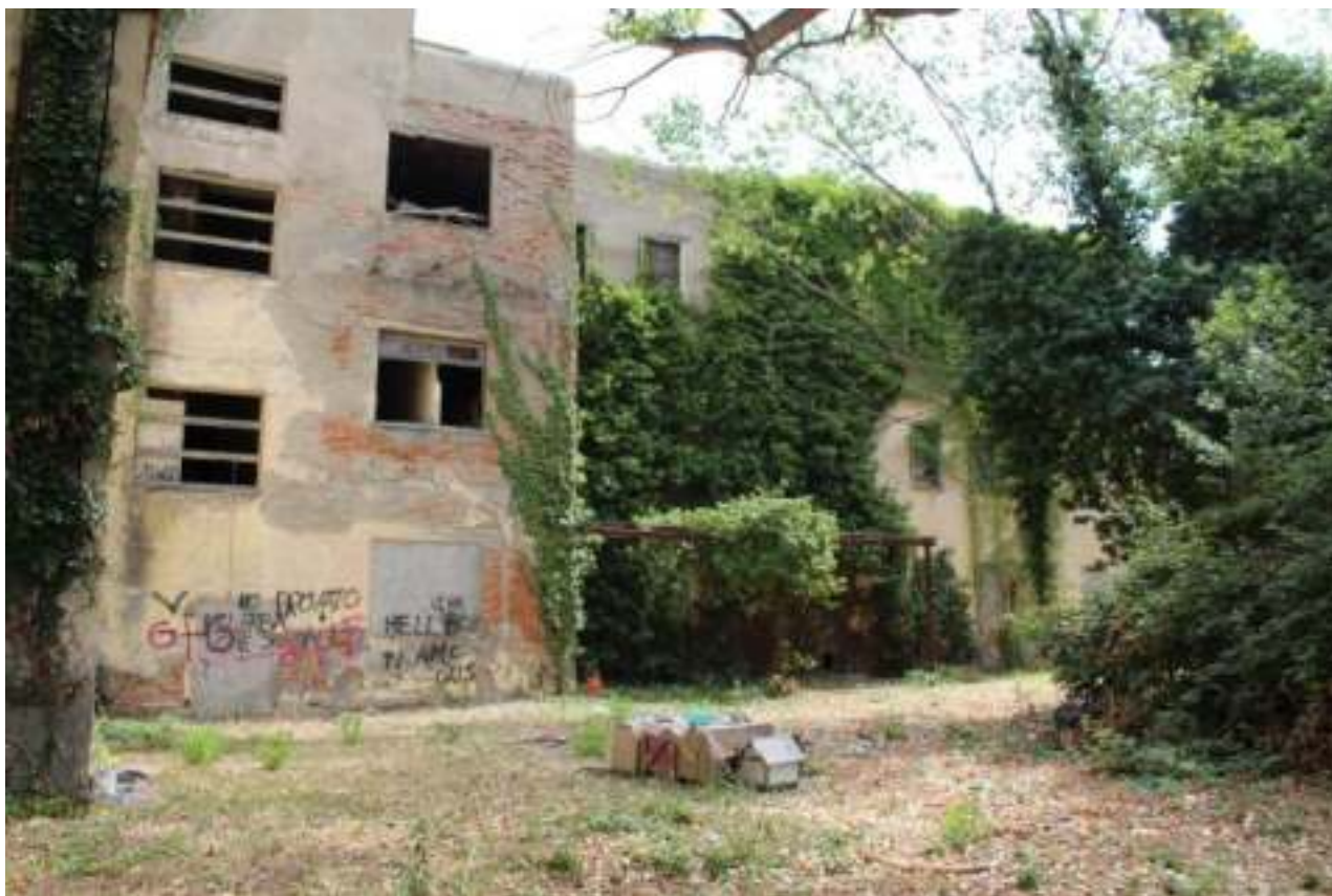
FOTO 7 – PROSPETTO OVEST – VIALE DEI MILLE
