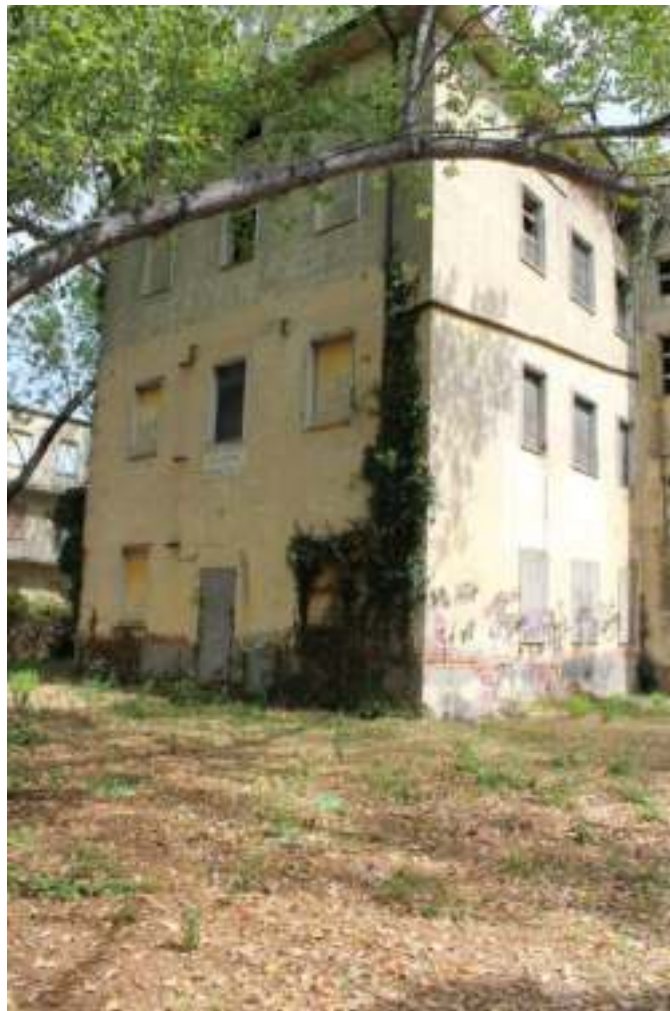
FOTO 5 – PROSPETTO OVEST – VIALE DEI MILLE
