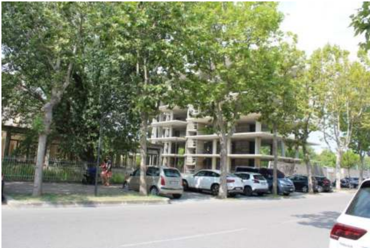
FOTO 5 – PROSPETTO SUD-EST CON VISTA A SINISTRA, DELLA FATISCENTE COSTRUZIONE CONFINANTE
