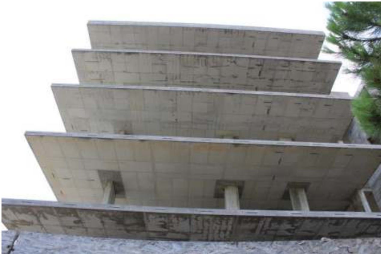
FOTO 7 – PARTICOLARE DEI SOLAI
